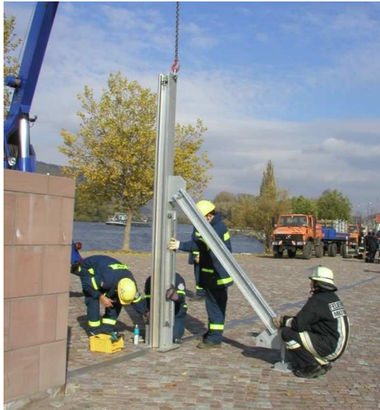
Abb. 80: Aufbau Stütze (HWS Miltenberg) [www.wwa-ab.bayern.de]
