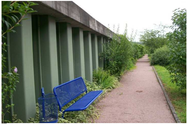
Abb. 70: Spundwand mit Kopfbalken (Hochwasserschutz Rothenfels)
