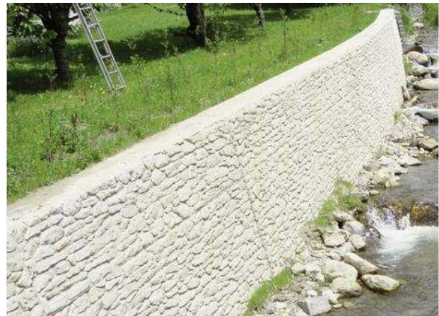
Abb. 75: Oberflächenbearbeitung mit Strukturmatrizen [Fa. Reckli, Produktkatalog]
