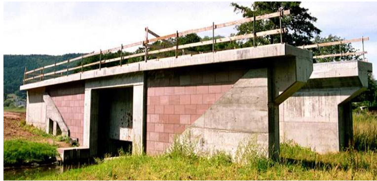
Abb. 98: Absperrbauwerk (Deich) im Bau (HWS Miltenberg) [www.wwa-ab.bayern.de]
