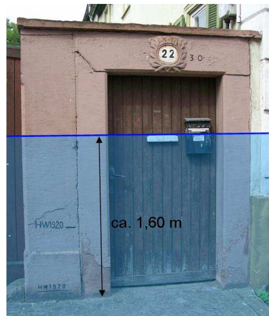
Abb. 26: Eingang Hauptstr. 22 bei HQ 100
