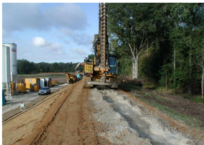
Abb. 67: Herstellung einer MIP-Wand [www.wwa-in.bayern.de]
