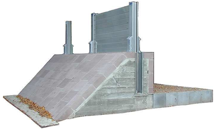
Abb. 84: kombinierte HWS-Wand (HWS Miltenberg) [WWA AB, Faltblatt, 2008]
