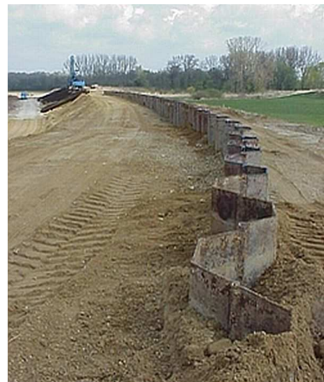
Abb. 64: eingebaute Spundwand [www.wwa-la.bayern.de]
