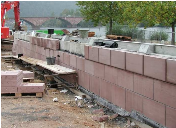
Abb. 74: Sandsteinverblendung HWS Miltenberg [www.wwa-ab.bayern.de]
