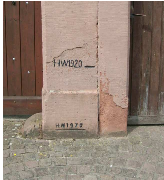
Abb. 48: Hochwassermarken am Eingang Hauptstr. 22
