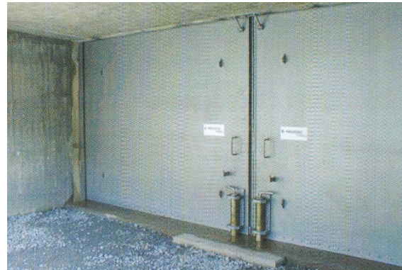
Abb. 77: HWS-Tor in Rothenfels (geschlossen) [WWA WÜ, Faltblatt, 1998]
