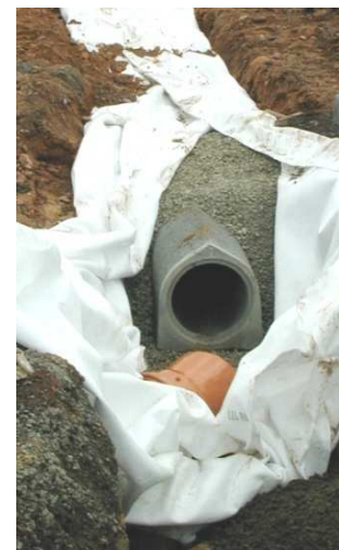
Abb. 89: Dranleitung beim Einbau [www.wwa-ab.bayern.de]
