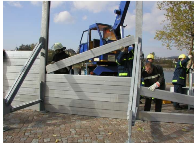
Abb. 81: Einbau Wandelemente (HWS Miltenberg) [www.wwa-ab.bayern.de]
