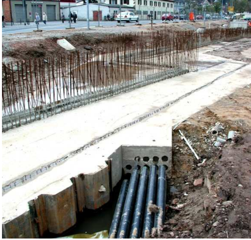
Abb. 91: Leitungsquerung [ www.wwa-ab.bayern.de ]
