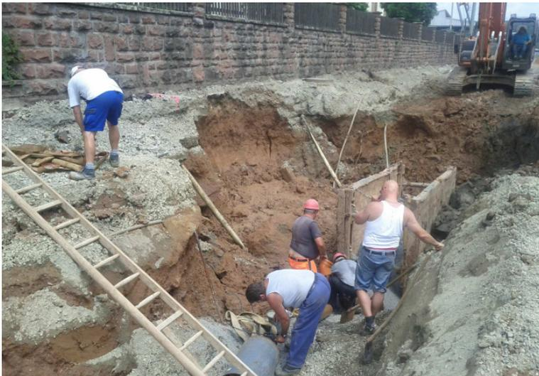
Zu nicht erwarteten Verzögerungen kam es bei den Kanalbauarbeiten in der Marktheidenfelder Straße. Entgegen der Prognose der vorherigen Bodenuntersuchung kam es zu massiven Wasseransammlungen und Ausspülungen im Kanalgraben. Der Weiterbau ist deshalb nur mit stützenden Spundwänden möglich, die Kosten werden sich hierdurch leider erhöhen.
